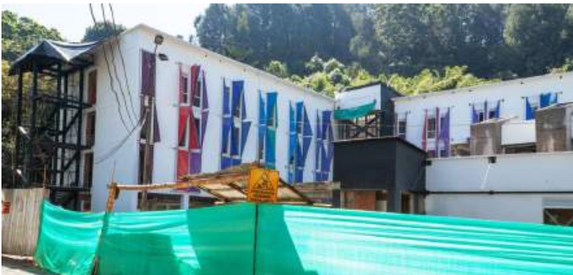
Avance de la obra del edificio de Residencias Universitarias en 2023
