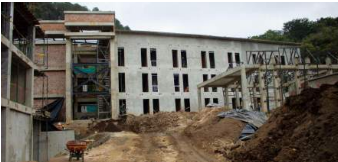
Obra del edificio de Residencias Universitarias en 2022.
